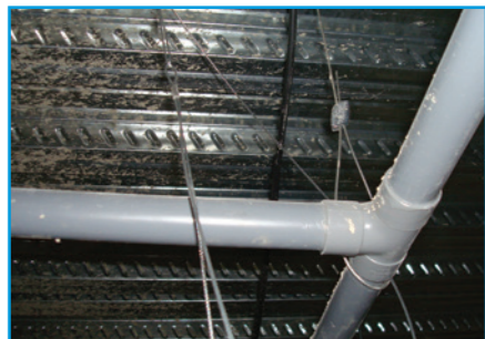
Condensate pipes
