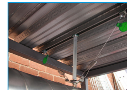
Longitudinal Bracing
