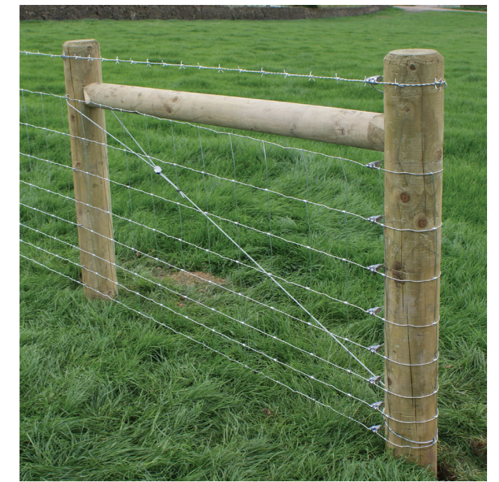
Gパック3 - 端柱への施工例
