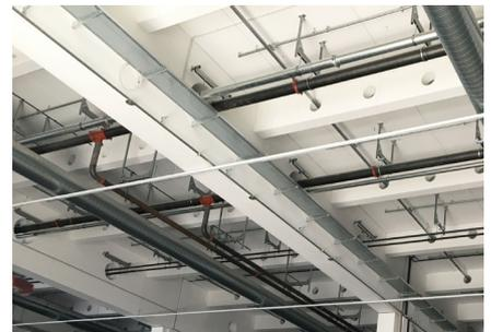
“Die Gripple Seile waren sehr schnell montiert. Ein besonders großer Vorteil war die **unkomplizierte und schnelle Feinjustierung der Leuchten**, da die Hallen eine leichte Dachschräge hatten.”
